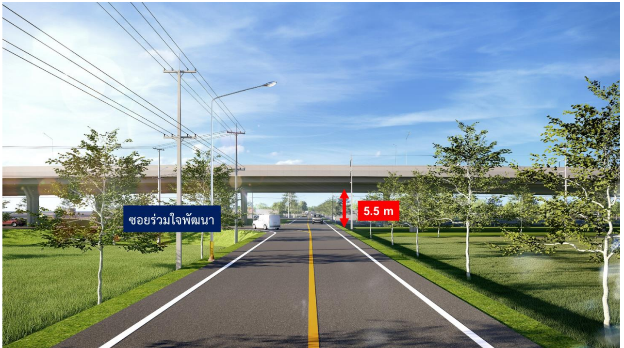
รูปที่ 4-5 สะพานระดับสูงข้ามขอความร่วมมือพัฒนา ความยาวช่วงมากกว่า 20-30 เมตร ภาพเสมือนจริง
