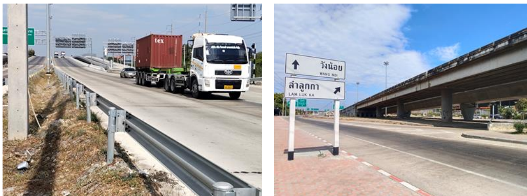
TMC 1 จุดตัด ทล.352 และ ทล.305
